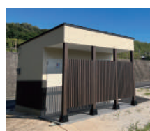
屋外多目的トイレ
